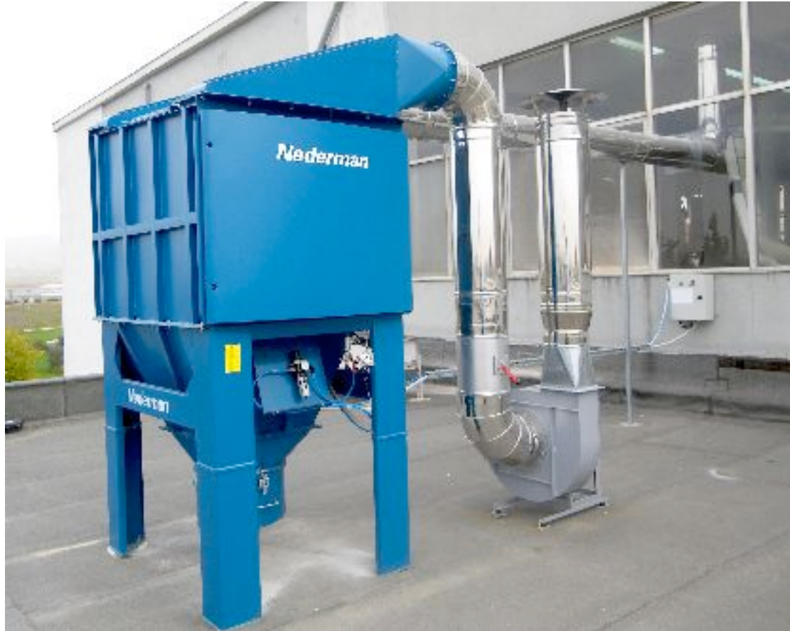
Η ΝΕΑ ΑΝΤΙΕΚΡΗΚΤΙΚΗ ΕΓΚΑΤΑΣΤΑΣΗ ΑΠΑΓΩΓΗΣ ΣΚΟΝΗΣ ΣΤΟ ΕΡΟΣΤΑΣΙΟ ΘΕΣΣΑΛΟΝΙΚΗΣ
