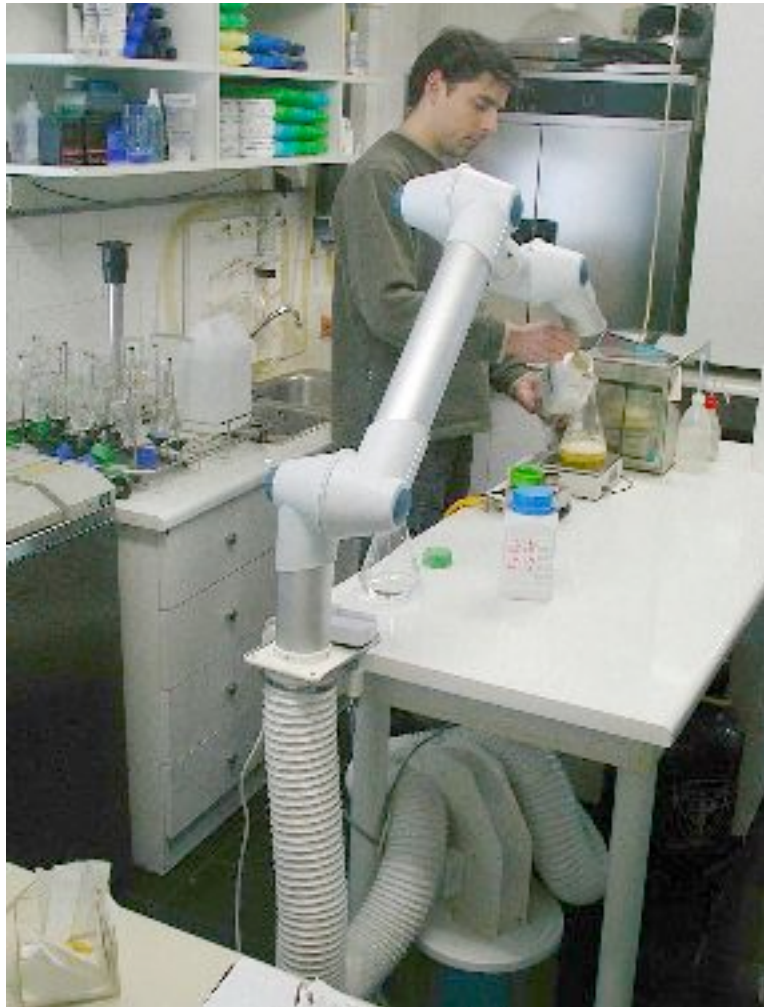
Βιομηχανία καλλυντικών RILKEN - Απορρόφηση αναθυμιάσεων και οσμών κατά την ζύγιση
