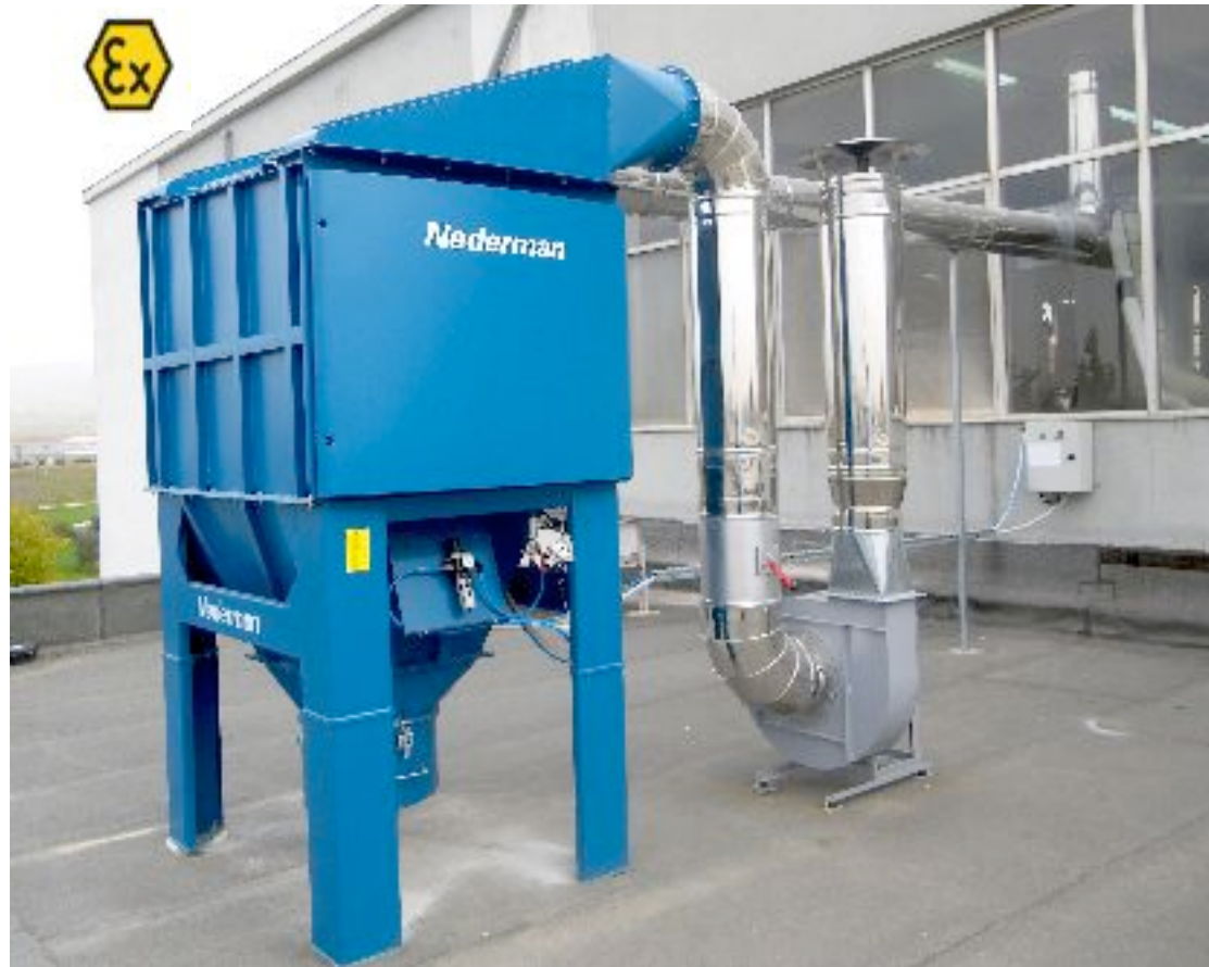
Ι.Ε.ΠΑΠΑΔΟΠΟΥΛΟΣ ΑΕ Η ΝΕΑ ΑΝΤΙΕΚΡΗΚΤΙΚΗ ΕΓΚΑΤΑΣΤΑΣΗ ΑΠΑΓΩΓΗΣ ΣΚΟΝΗΣ ΣΤΟ ΕΡΓΟΣΤΑΣΙΟ ΘΕΣΣΑΛΟΝΙΚΗΣ
